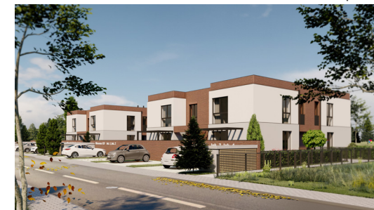
Widok od strony ulicy
